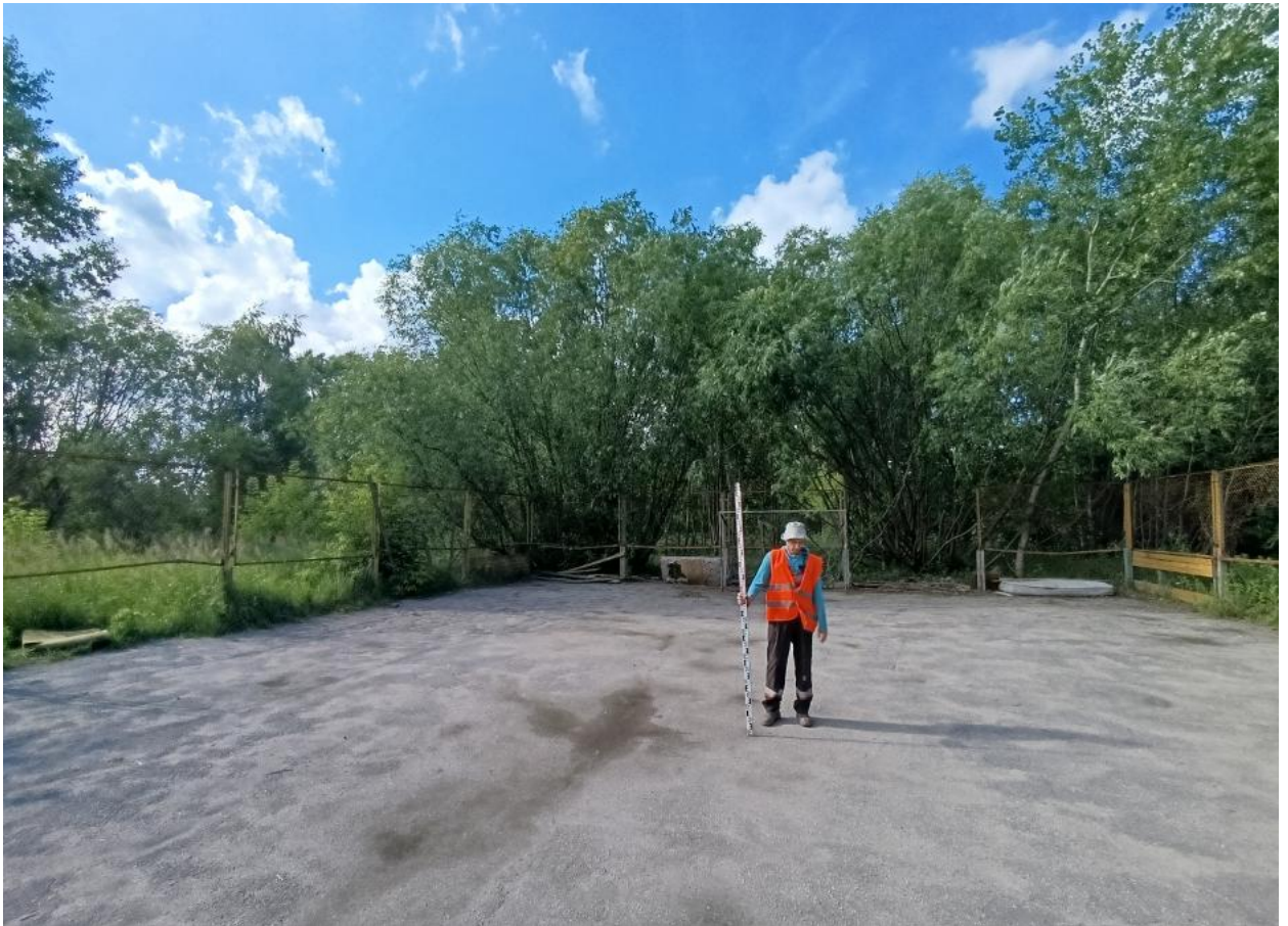
Илл. 6. «Строительство спортивного клуба». Точка фотофиксации 1. Вид с Ю.
