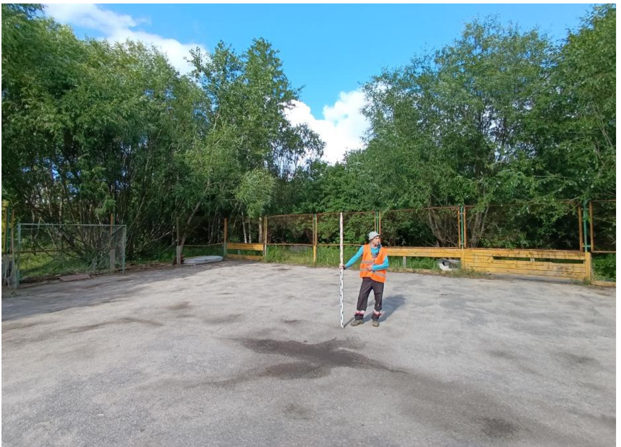
Илл. 7. «Строительство спортивного клуба». Точка фотофиксации 1. Вид с ЮЗ.
